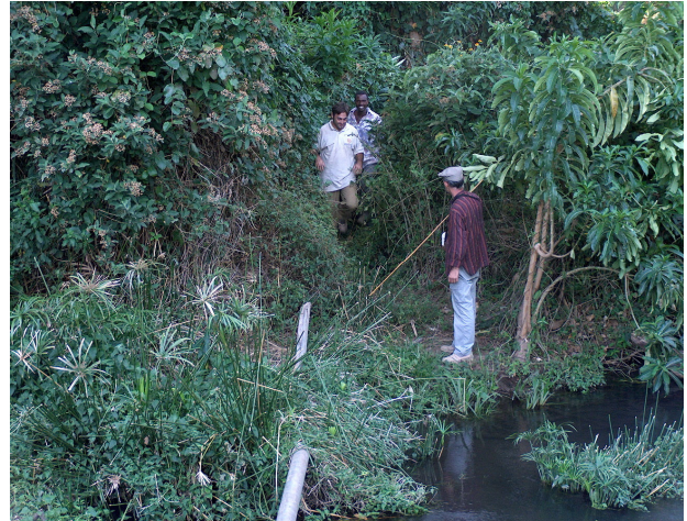
Figura 22 Tubería de alimentación a la bomba de ariete. (Barazani, Tanzania, M.onzález 2005)
