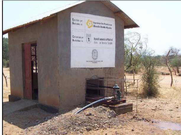
Figura 3 Moto-bomba accionada por correas en Mbuga Nyekundu (Mangola, Tanzania, J.A.Mancebo 2007)
