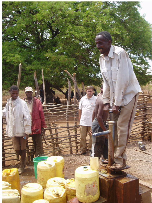
Figura 12 Bomba manual de émbolo sumergido en Kambi ya Simba (Mangola, Tanzania, J.A.Mancebo 2005)
