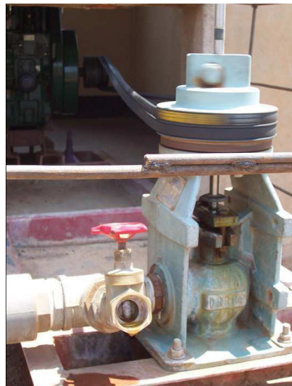
Figura 4 Detalle de transmisión por correa (bomba de Fig.3, J.A.Mancebo 2007)
