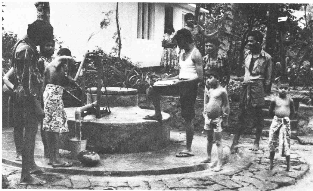
Fig. 1. Vista del pozo donde se ve el canal de desagüe para el agua derramada y la capa de piedra que ayuda al drenaje.
